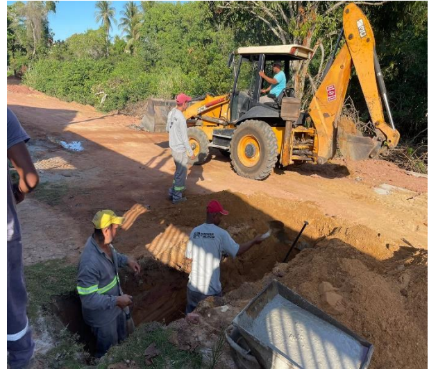
Escavação manual de vala.
