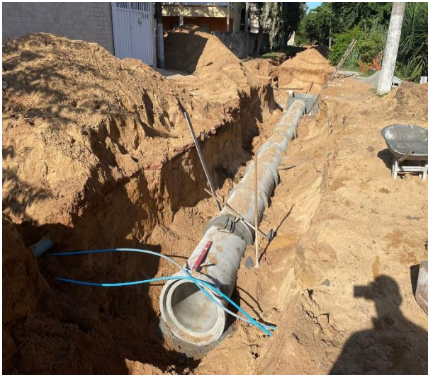
Religação de rede de água DN 20mm.
