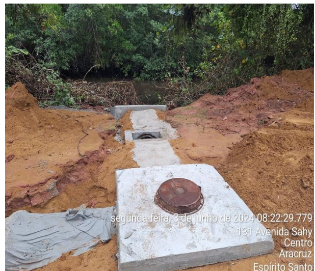
Execução de poço de visita.
