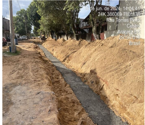
Execução de envelopamento com concreto.
