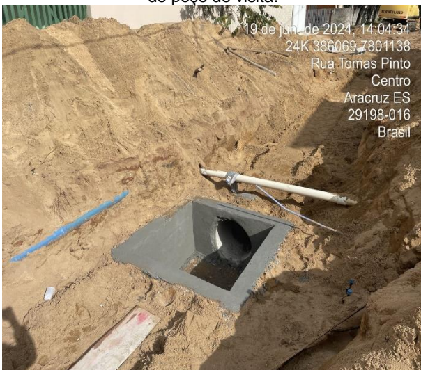
Execução de poço de visita.
