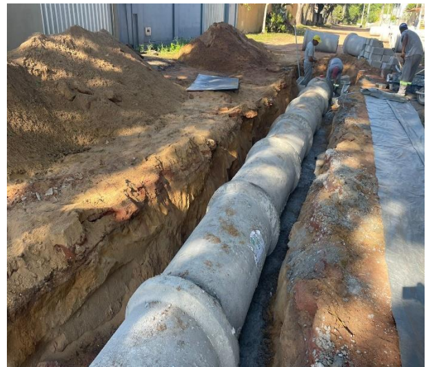
Assentamento de BSTC DN 0,60m e execução de berço de concreto.
