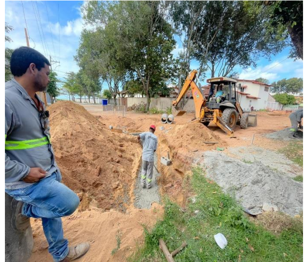
Execução de berço de concreto.
