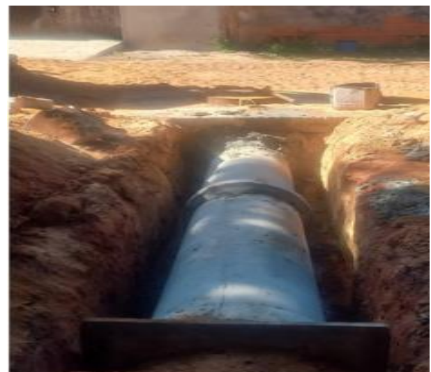
Assentamento de BSTC DN 0,40m.
