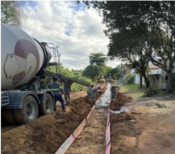
Transporte com caminhão betoneira.
