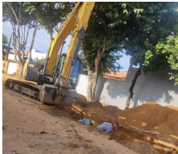
Escavação de material de primeira categoria.
