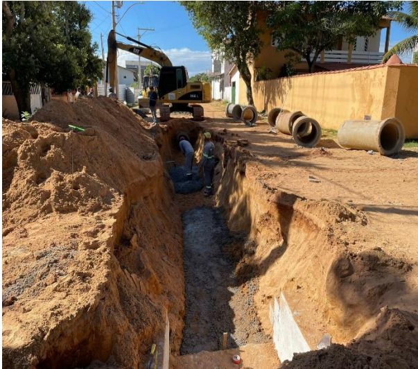
Execução de berço de concreto.
