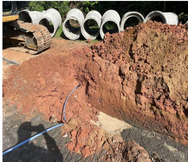
Religação de rede de água DN 20mm.
