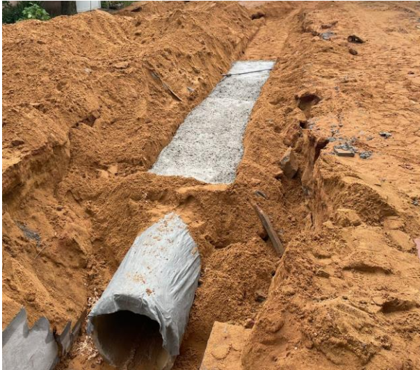
Aplicação de manta geotêxtil e envelopamento de concreto.
