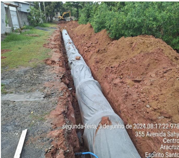
Assentamento de BSTC DN 0,60m.
