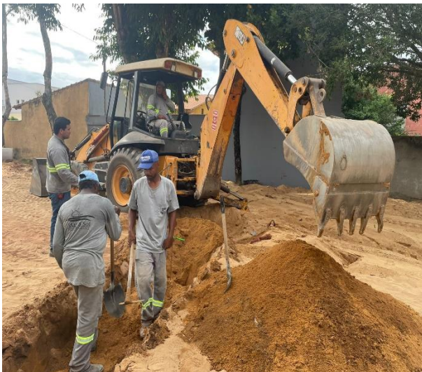
Reaterro com areia.
