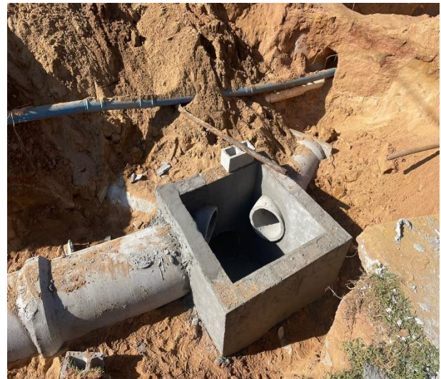
Execução de poço de visita.
