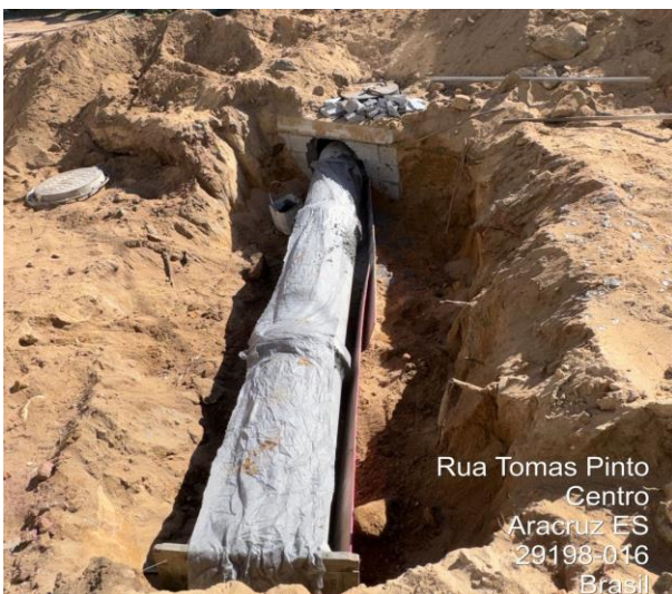
Assentamento de BSTC DN 0,40m.
