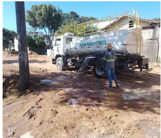
Reaterro com areia e adensamento hidráulico.
