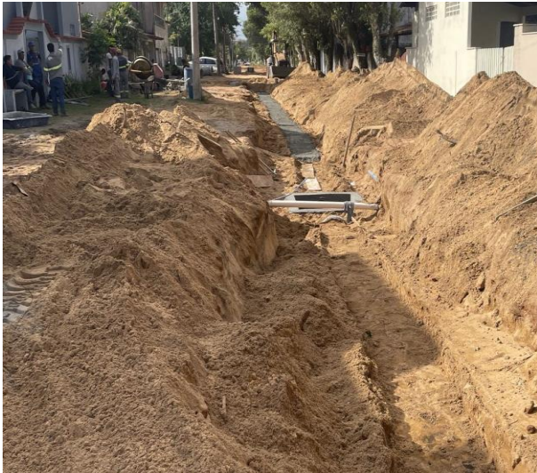
Remanejamento de rede de esgoto.
