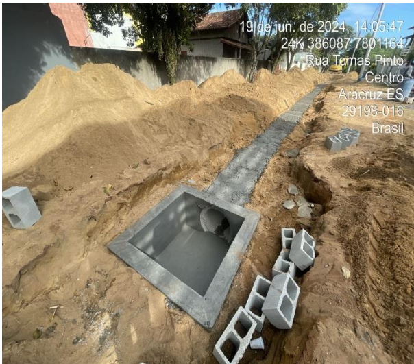
Execução de envelopamento com concreto e execução de poço de visita.
