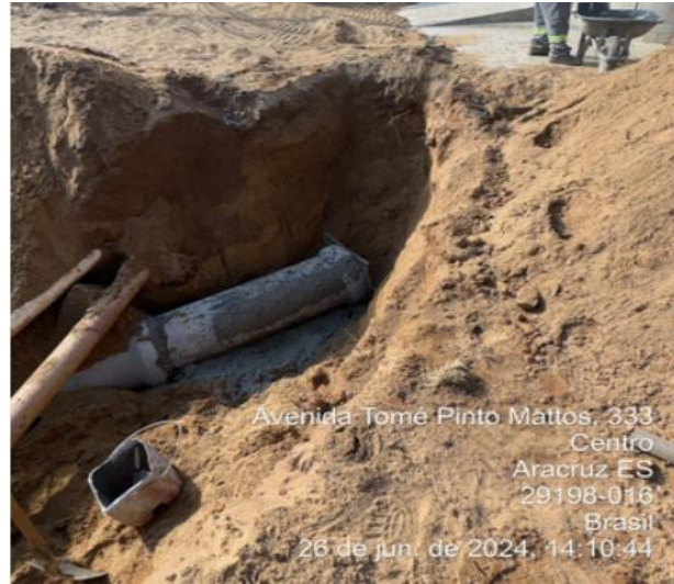
Remanejamento de rede de esgoto.
