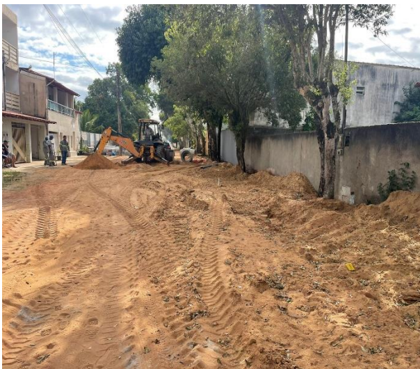
Escavação de material de primeira categoria.
