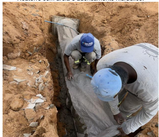
Aplicação de manta geotêxtil.
