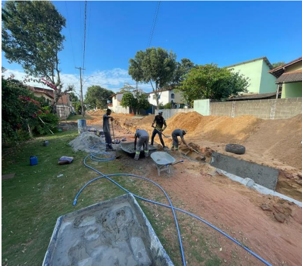
Execução de contra berço de concreto.
