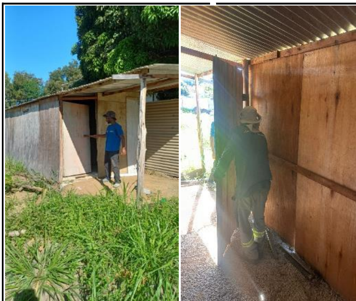
Foto 21 - Montagem de Barracão e Canteiro de Obras.
