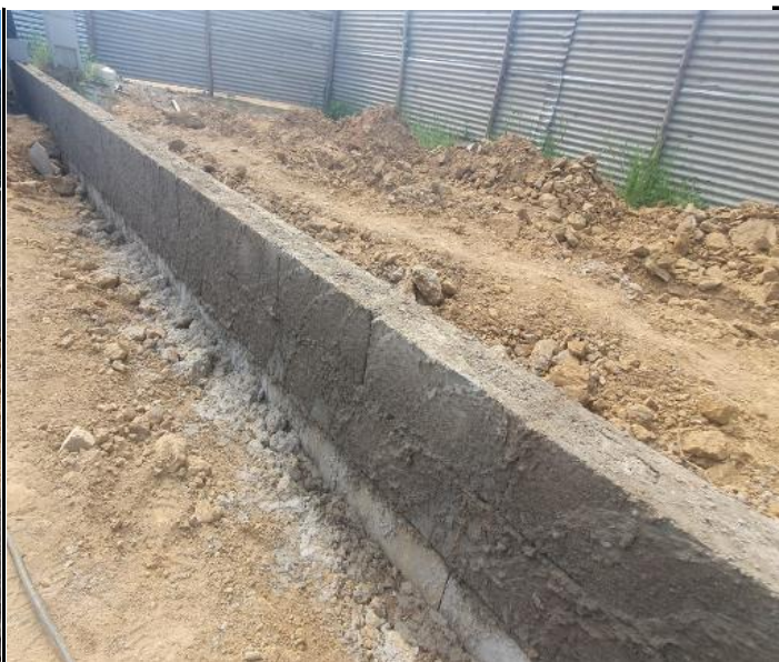
Foto 38 - Chapisco em alvenaria.
