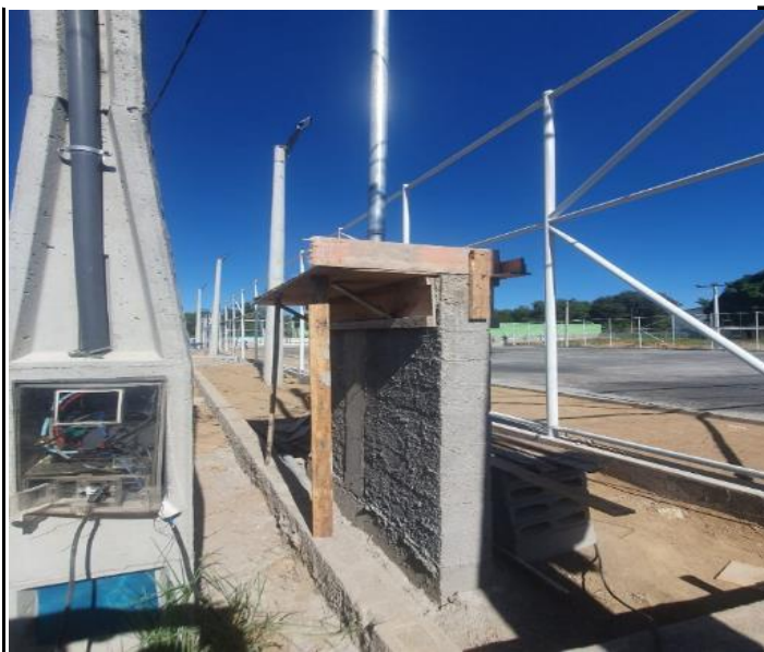
Foto 46 - Chapisco de alvenaria do padrão e construção do chapim.
