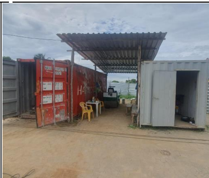
Foto 22 - Montagem de Canteiro de Obras.
