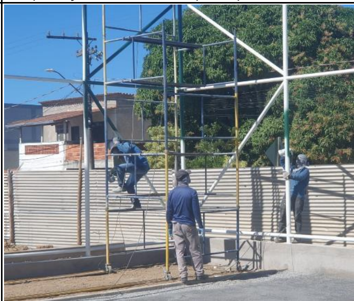
Foto 44 - Pintura de tubos do alambrado.
