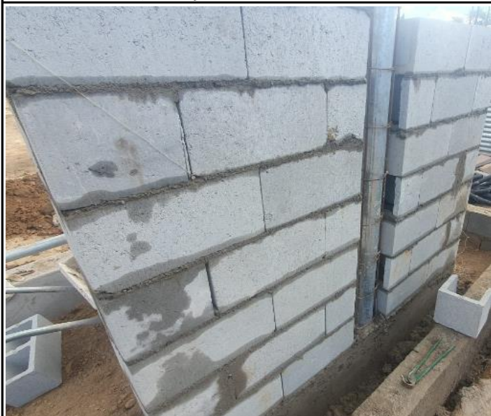
Foto 35 - Construção em alvenaria do padrão de energia.
