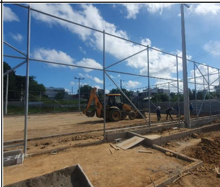
Foto 32 - Regularização e compactação de área aterrada.
