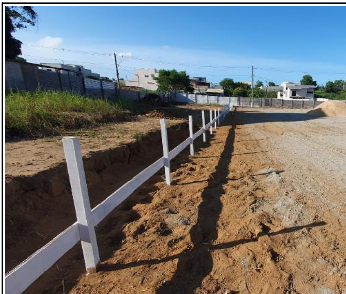
Foto 09 – Montagem de gabarito.
