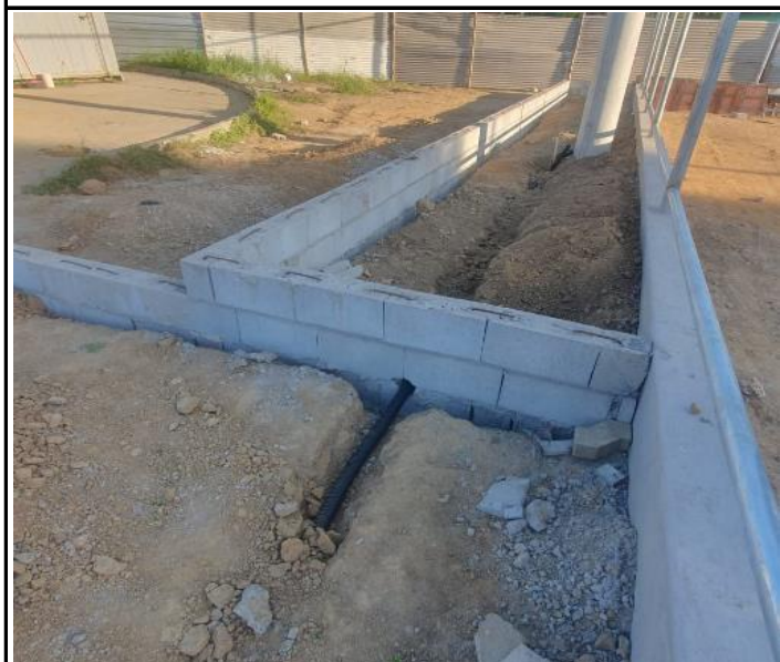
Foto 23 - Construção em Alvenaria de Canteiros e Rampa.
