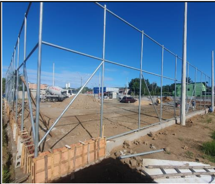
Foto 25 - Visão geral da obra, concretagem da contenção.
