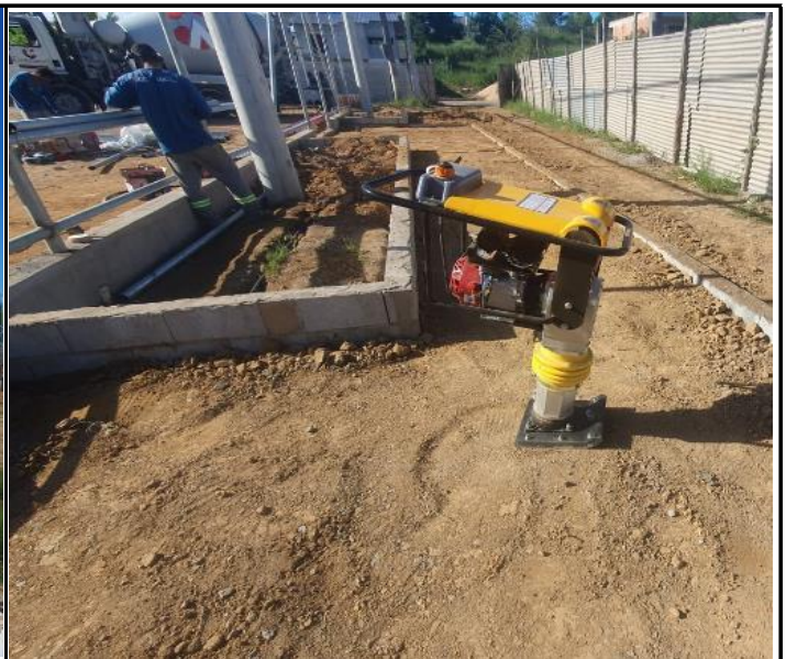
Foto 26 - Reaterro compactado de rampas e calçada externa.
