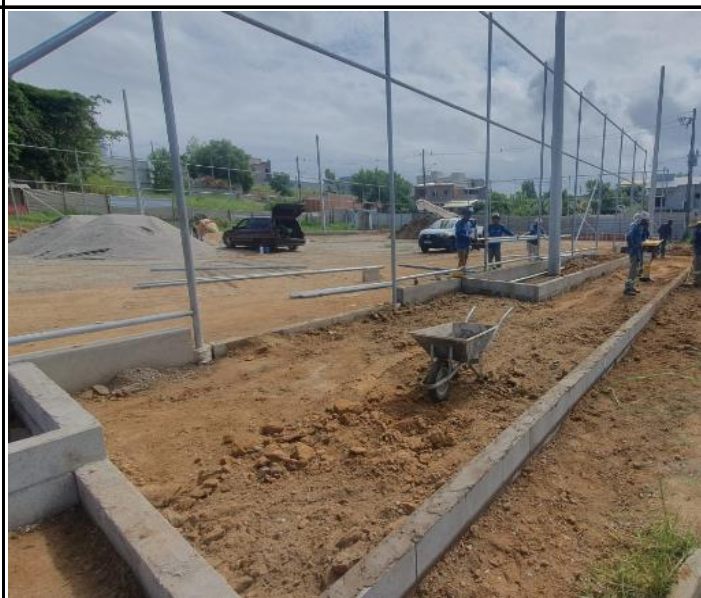
Foto 24 - Reaterro compactado de rampas e calçada externa.
