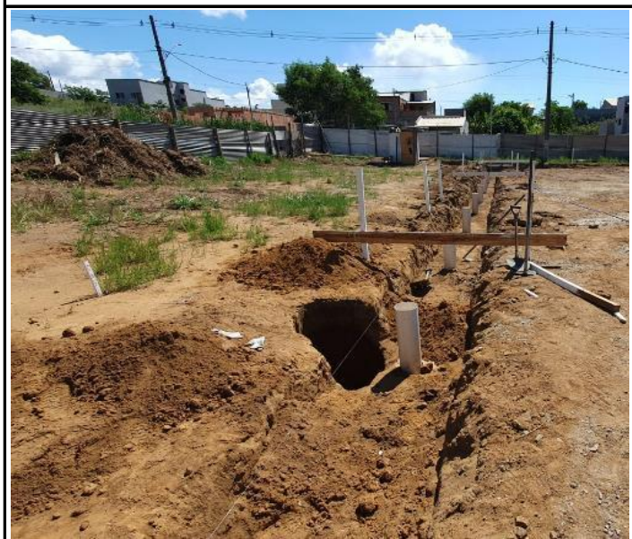
Foto 11 – Escavação das laterais do campo.
