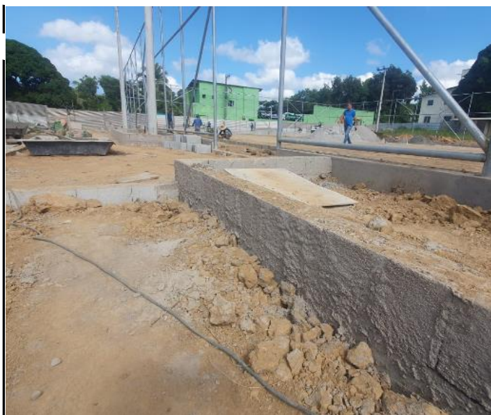
Foto 37 - Chapisco em alvenaria.
