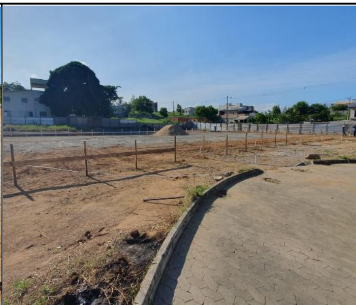
Foto 10 – Montagem de gabarito.
