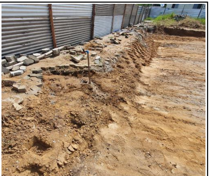
Foto 02 – Rede de água provisória.
