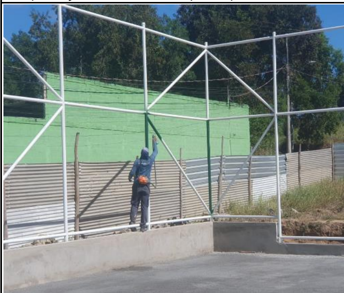
Foto 43 - Pintura de tubos do alambrado.
