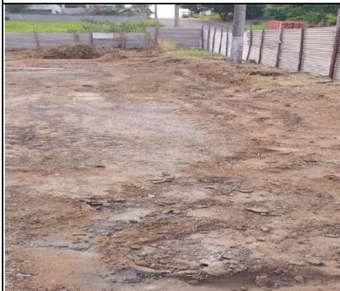
Foto 03 – Raspagem e limpeza do terreno.
