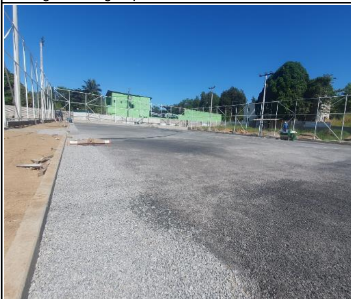
Foto 47 - Compactação de camada de pó de pedra.
