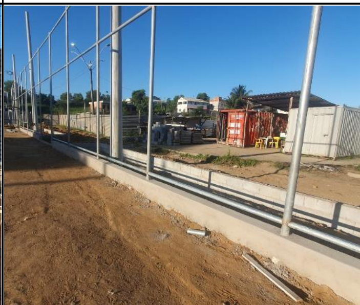
Foto 20 - Reboco em alvenaria de confinamento lateral do campo.
