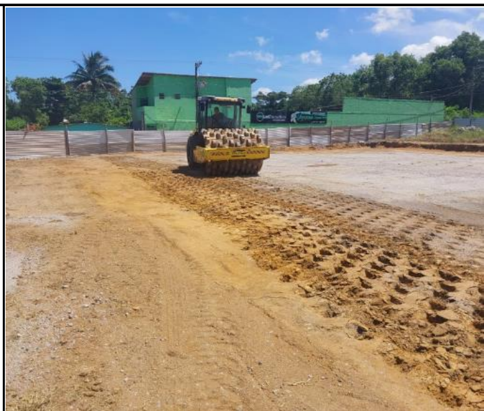
Foto 06 – Compactação do sub-leito.
