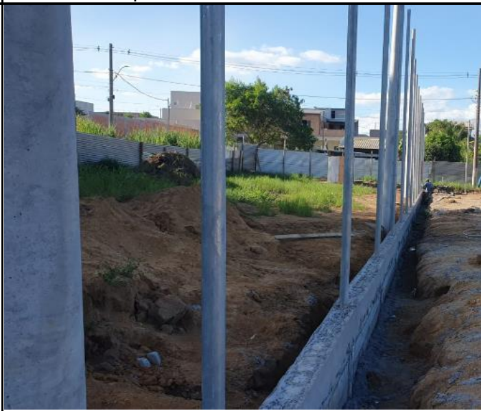
Foto 16 - Chapisco em alvenaria de confinamento lateral do campo.
