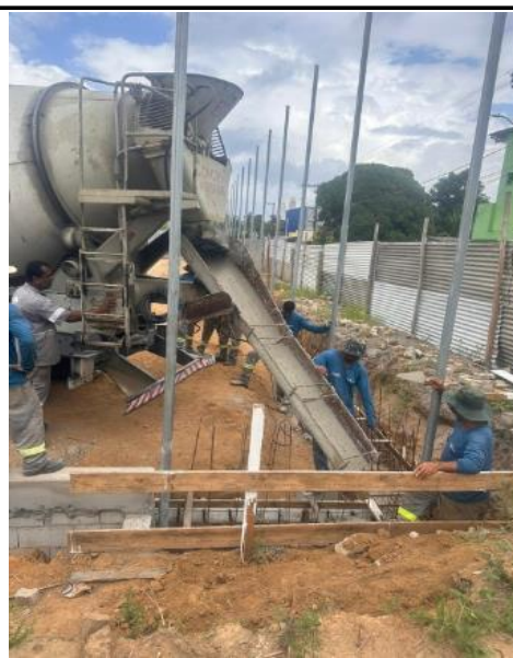
Foto 18 - Concretagem da base das contenções.
