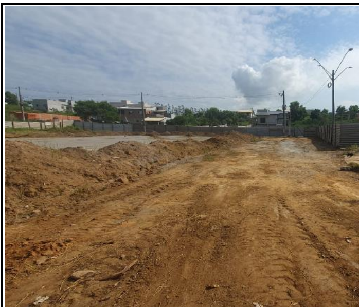
Foto 05 – Raspagem e limpeza do terreno.
