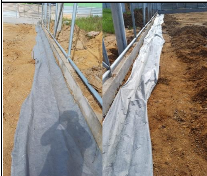
Foto 31 - Aplicação de manta drenante nas extremidades do campo.
