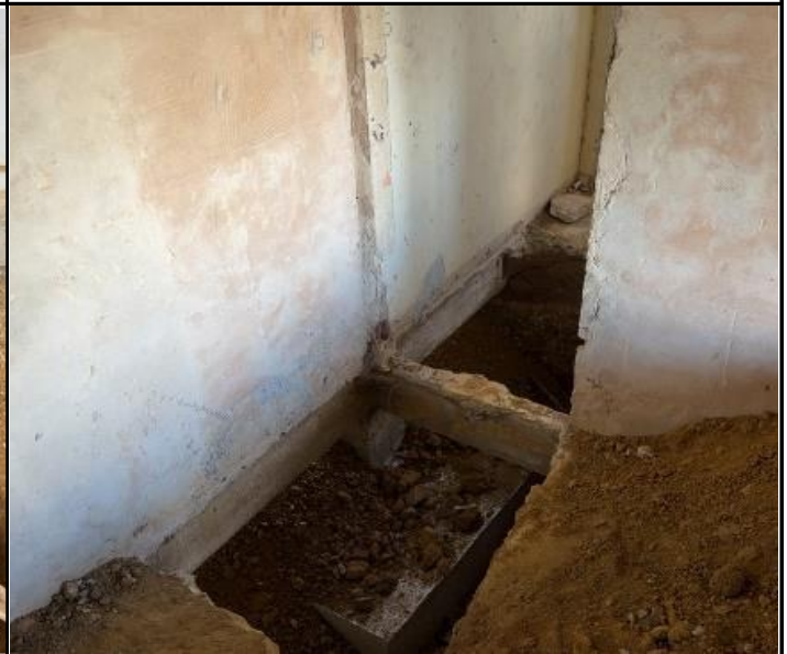
Foto 08 – Sapata Concretada.
