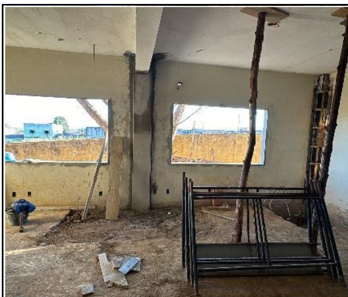
Foto 17 – Concretagem de Pilar.
