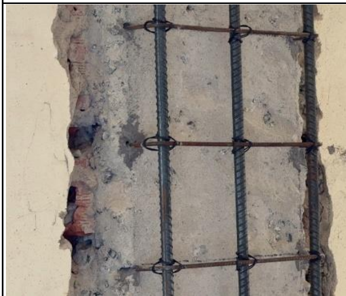
Foto 15 – Reforço estrutural em Pilar.
