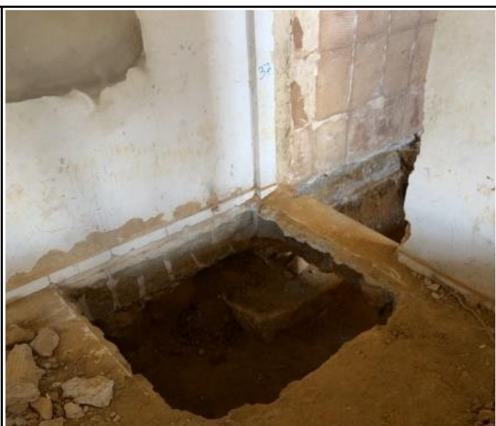
Foto 14 – Sapata Concretada.
