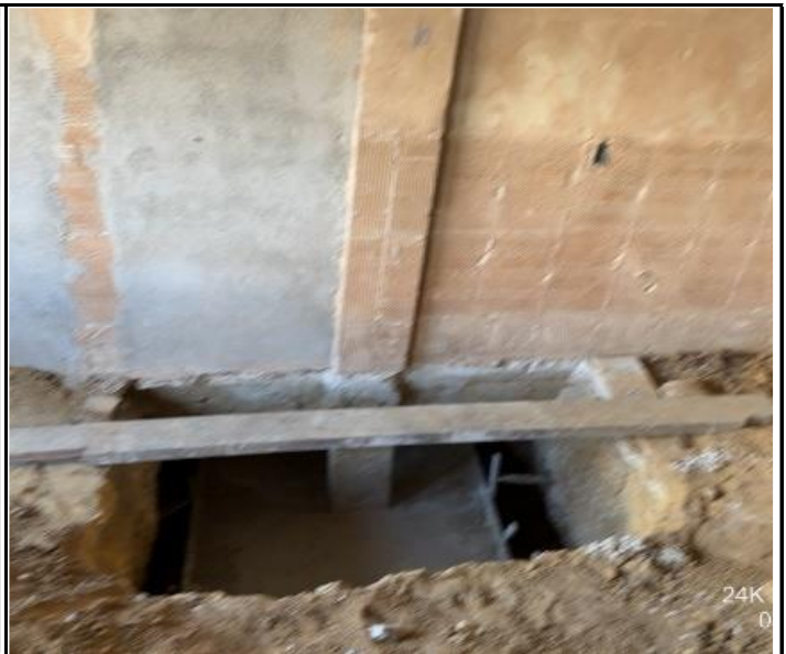
Foto 02 – Sapata Concretada.
