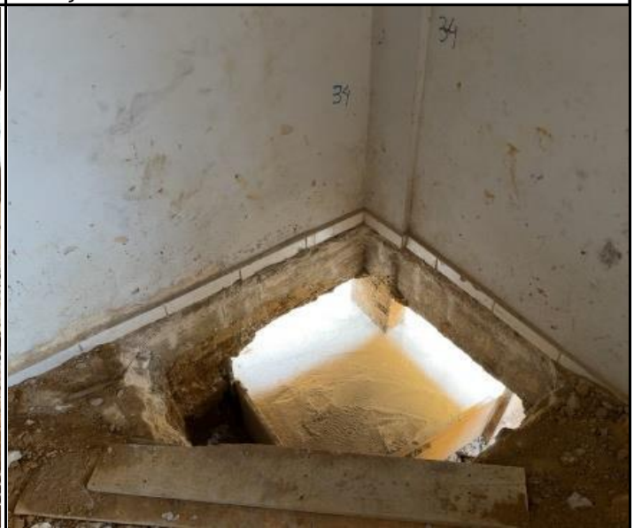
Foto 12 – Sapata Concretada.
