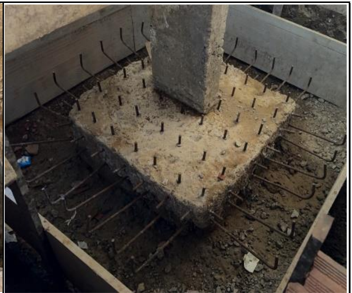
Foto 10 – Montagem de Sapata (Aço e Forma) para reforço estrutural.
