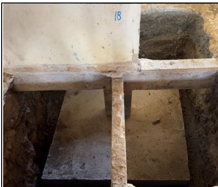
Foto 13 – Sapata Concretada.
