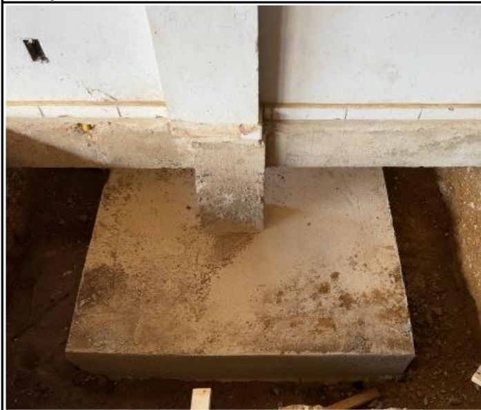
Foto 07 – Sapata Concretada.
