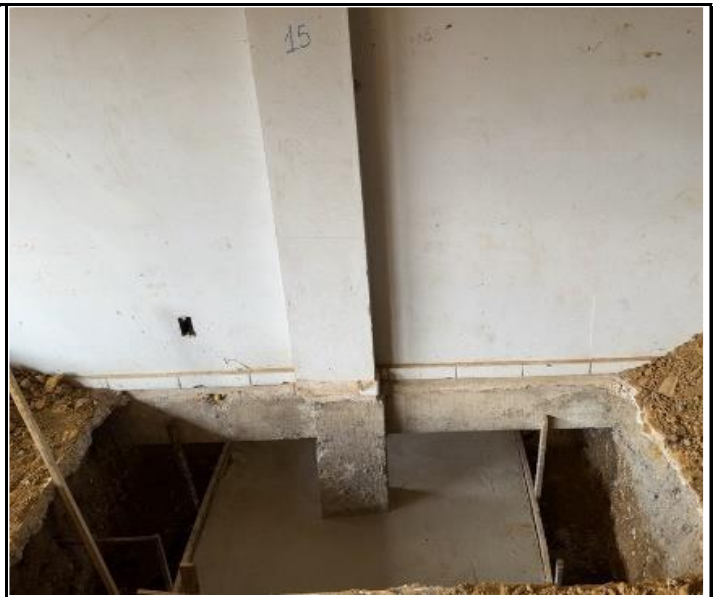
Foto 06 – Sapata Concretada.
