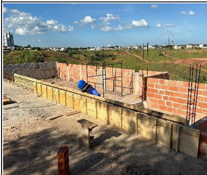
Foto 19 – Montagem de Aço e Forma para reforço estrutural em viga.
