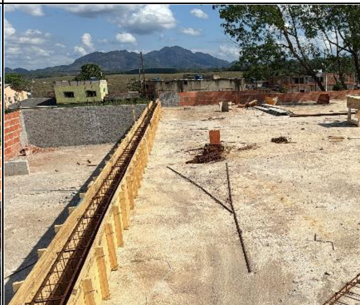
Foto 20 – Montagem de Aço e Forma para reforço estrutural em viga.
