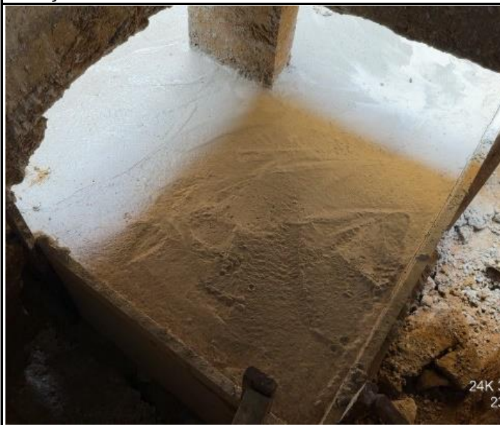
Foto 11 – Sapata Concretada.
