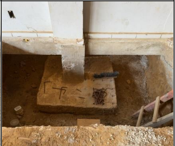
Foto 04 – Sapata Concretada.
