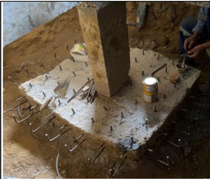
Foto 01 – Fixação de Aço com adesivo estrutural para reforço de Sapata
