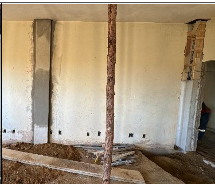
Foto 18 – Concretagem de Pilar.
