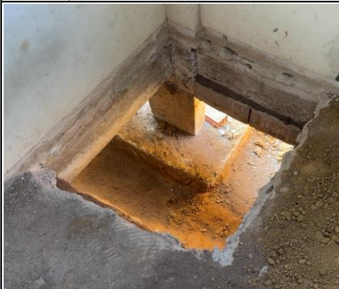
Foto 03 – Escavação Manual de Sapata.
