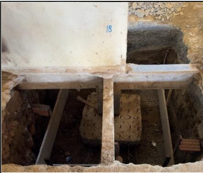
Foto 09 – Montagem de Sapata (Aço e Forma) para reforço estrutural.
