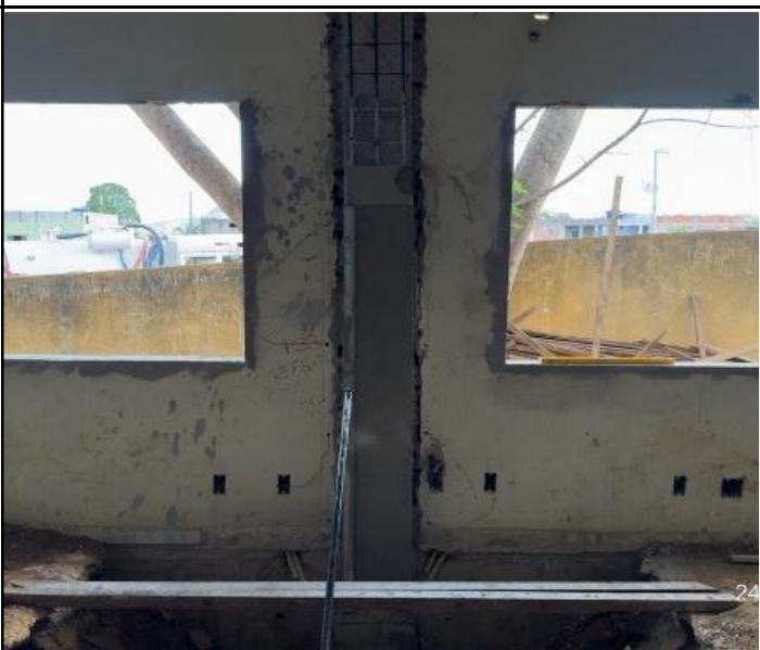
Foto 16 – Concretagem de Pilar.
