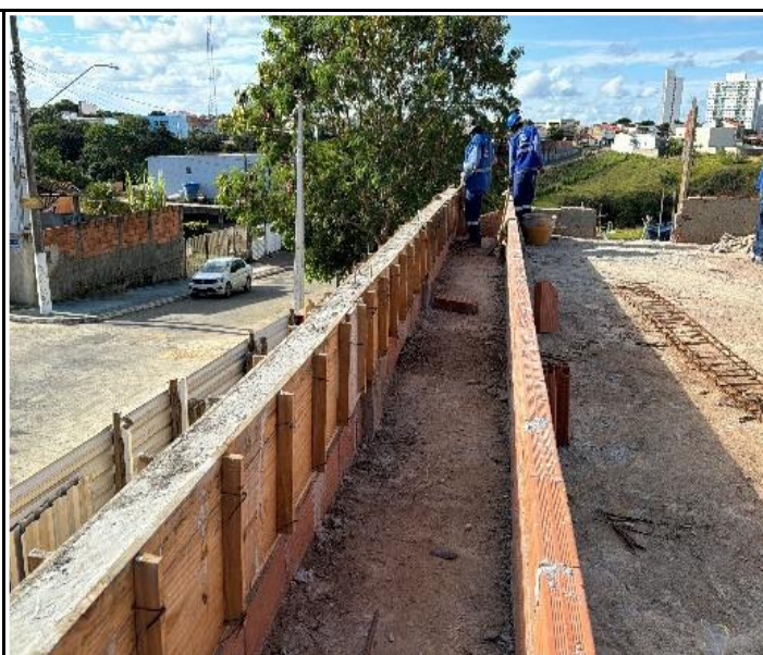
Foto 22 – Viga de Platibanda concretada.
