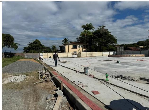
Foto 26 - Execução de ladrilho hidráulico
