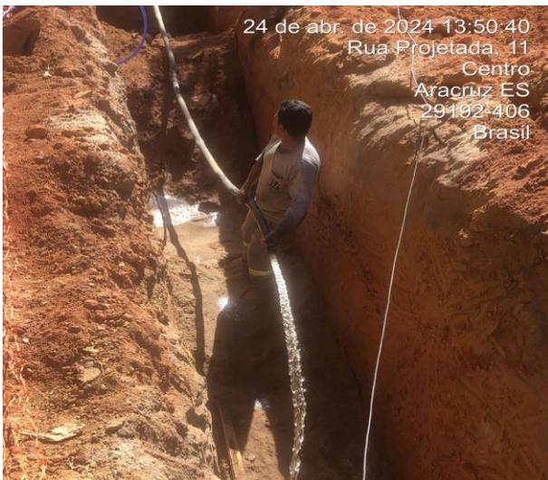
Reaterro com areia e adensamento hidráulico.
