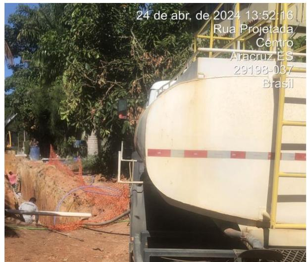
Reaterro com areia e adensamento hidráulico.
