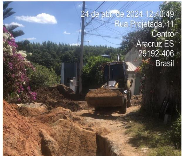
Reaterro com areia e adensamento hidráulico.
