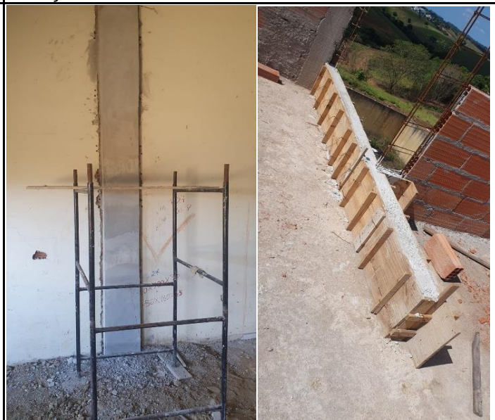
Foto 12 – Desforma de pilar Foto 13 - Reforço estrutural em viga.
