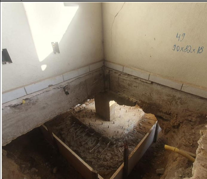
Foto 03 – Montagem de Sapata (Aço e Forma) para reforço estrutural.
