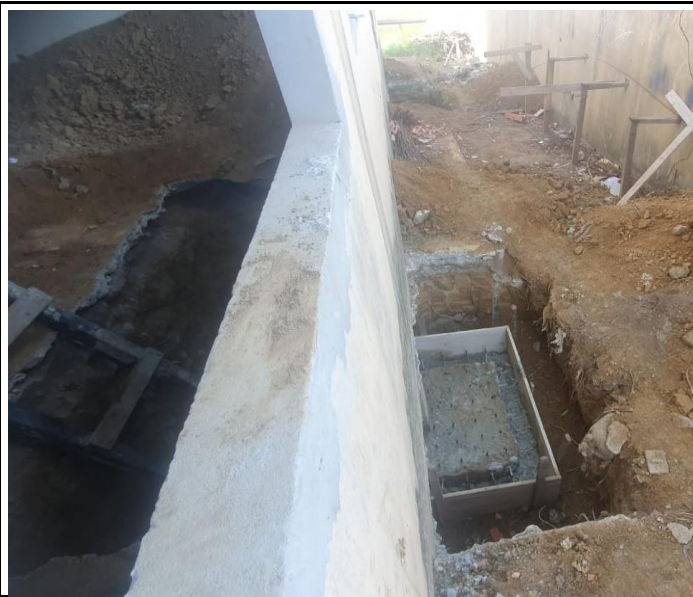
Foto 01 – Montagem de Sapata (Aço e Forma) para reforço estrutural.
