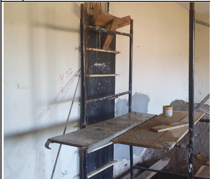
Foto 11 – Reforço estrutural em Pilar.
