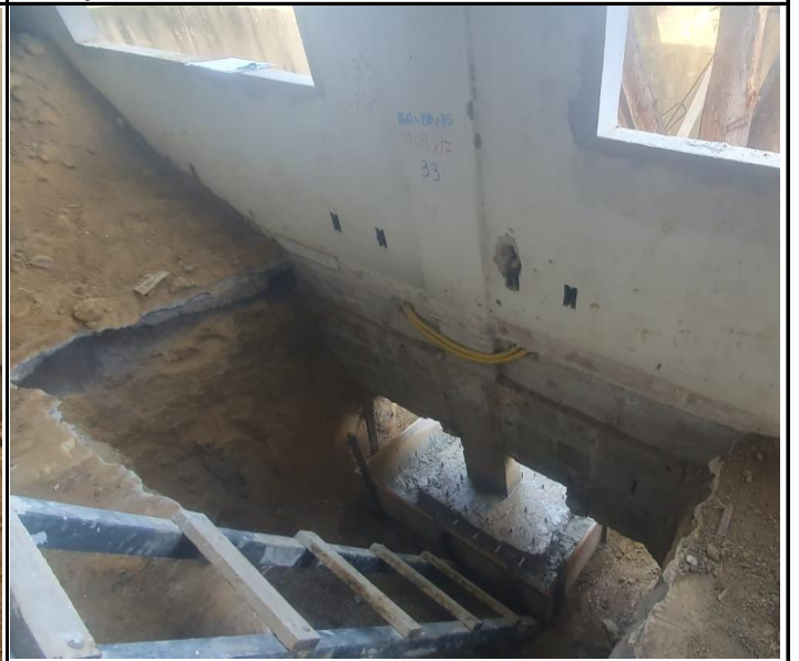
Foto 04 – Montagem de Sapata (Aço e Forma) para reforço estrutural.
