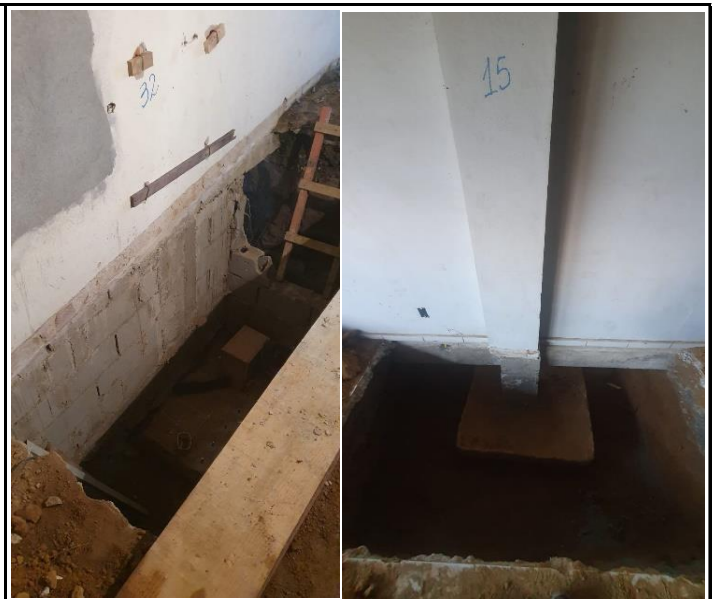
Foto 06 – Escavação manual para reforço de Sapata.
