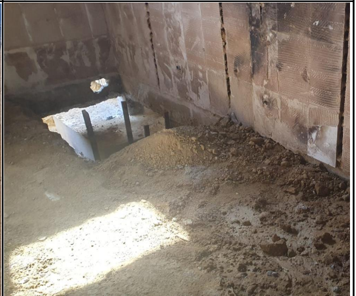
Foto 08 – Concretagem de sapatas.
