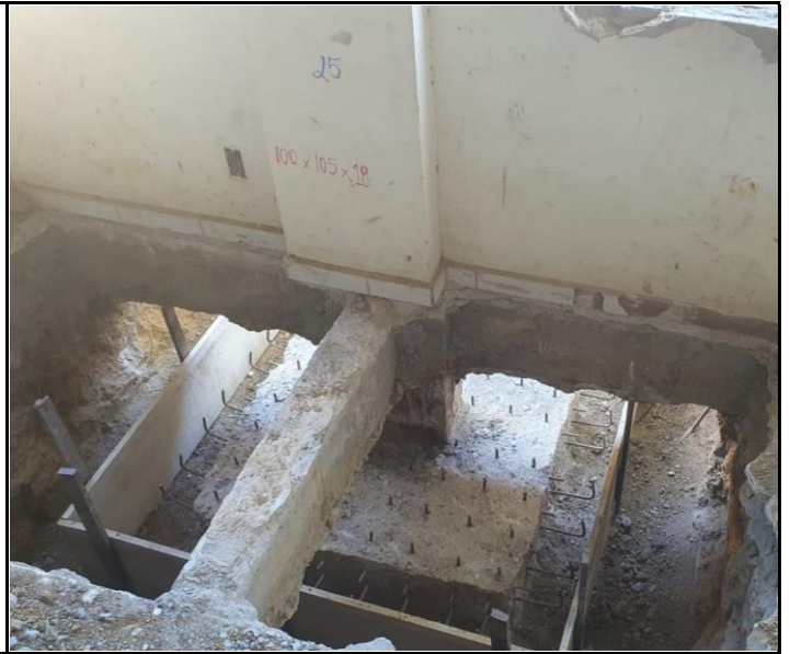
Foto 02 – Montagem de Sapata (Aço e Forma) para reforço estrutural.
