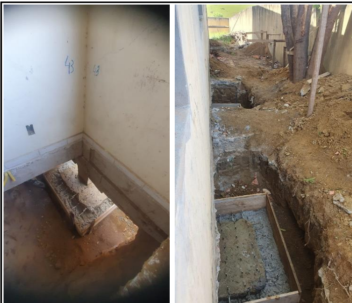
Foto 05 – Montagem de Sapata (Aço e Forma) para reforço estrutural.
