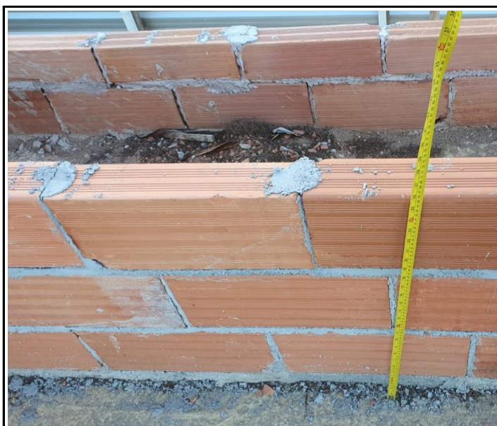
Foto 14 – Construção de alvenaria para calha.
