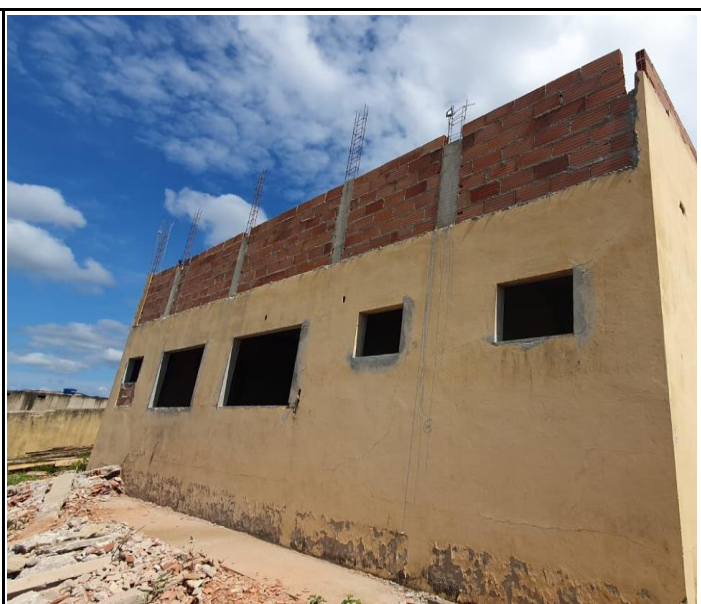
Foto 15 – Alvenaria da platibanda dos fundos.
