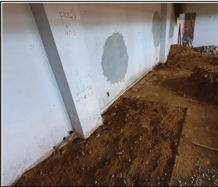
Foto 01 – Reaterro compactado de sapatas concretadas.
