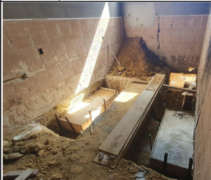
Foto 07 – Sapatas concretadas.
