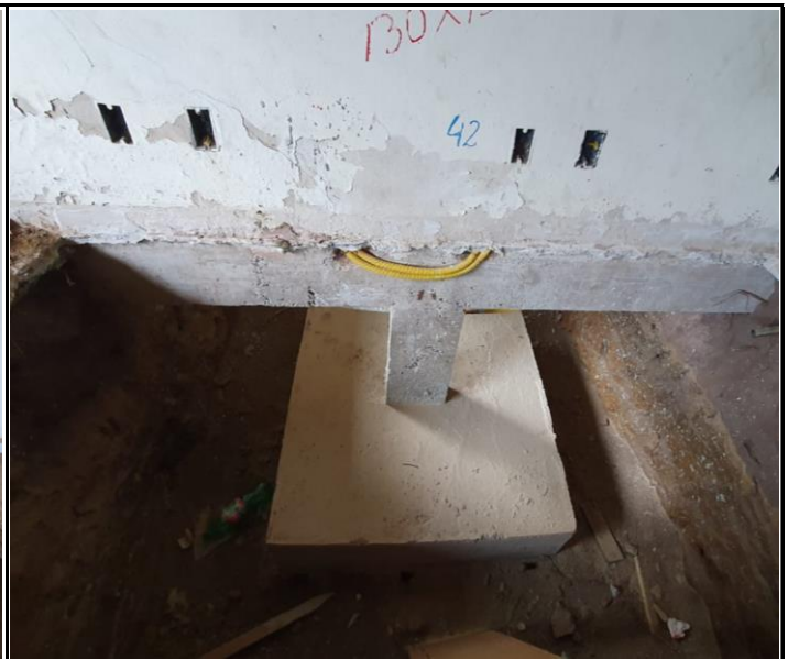
Foto 06 – Sapata concretada.
