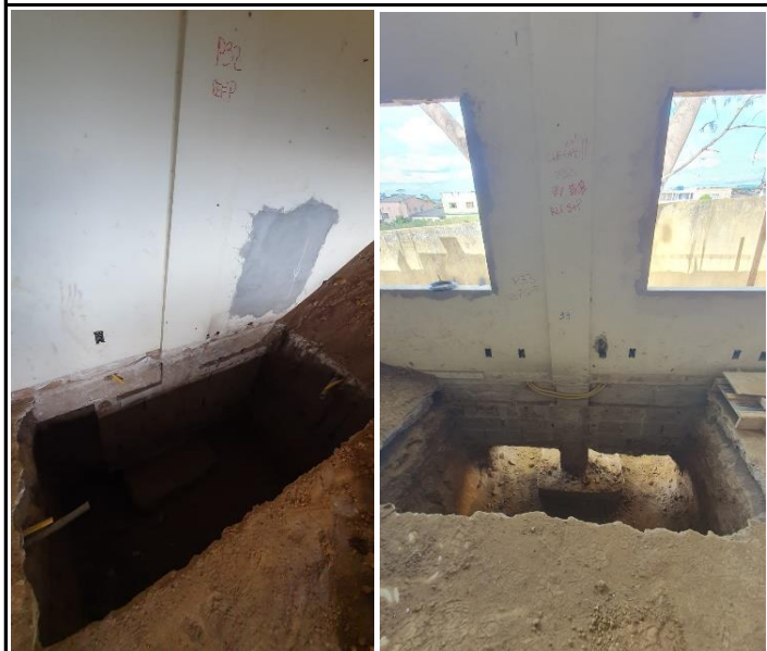
Foto 11 – Escavação de Sapatas.
