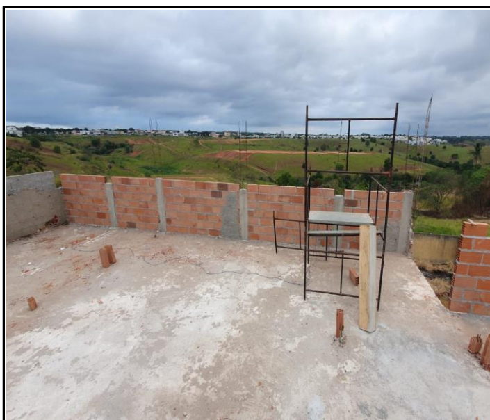
Foto 09 – Execução de platibanda em alvenaria.
