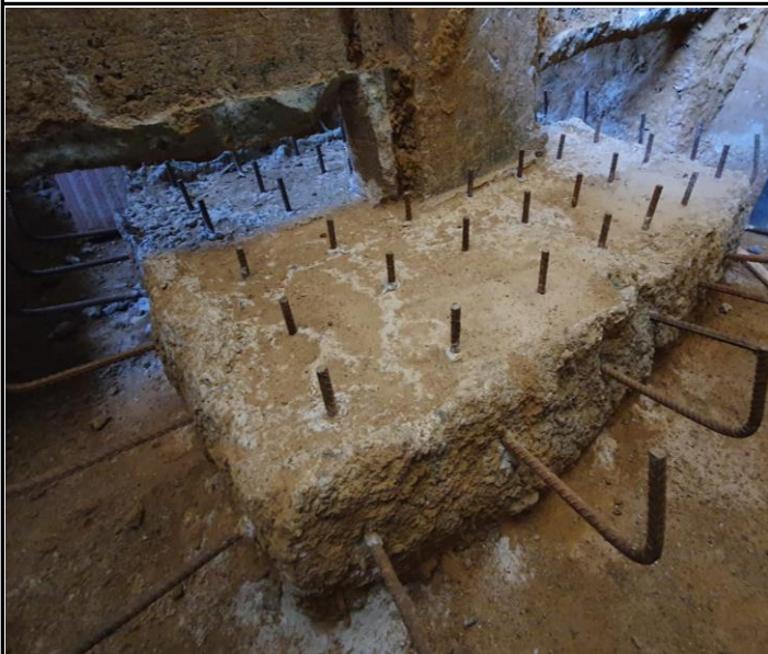
Foto 03 – Armação de reforço estrutural em Sapata.
