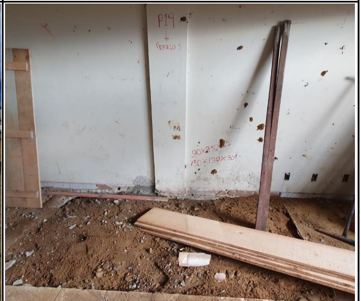
Foto 04 – Reaterro compactado de sapatas concretadas.
