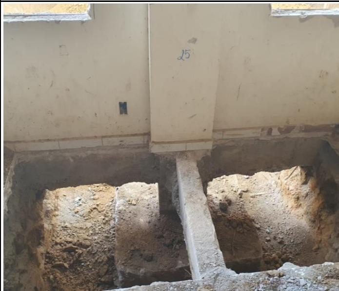
Foto 15 - Escavação de Sapatas.
