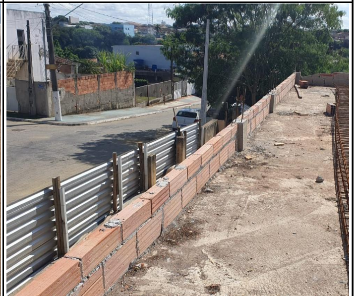
Foto 08 – Execução de platibanda em alvenaria.
