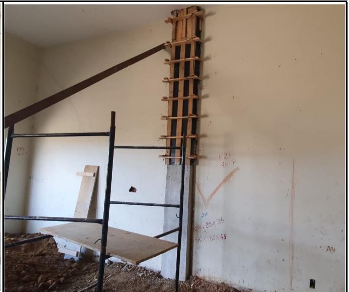
Foto 14 – Concretagem de pilar.
