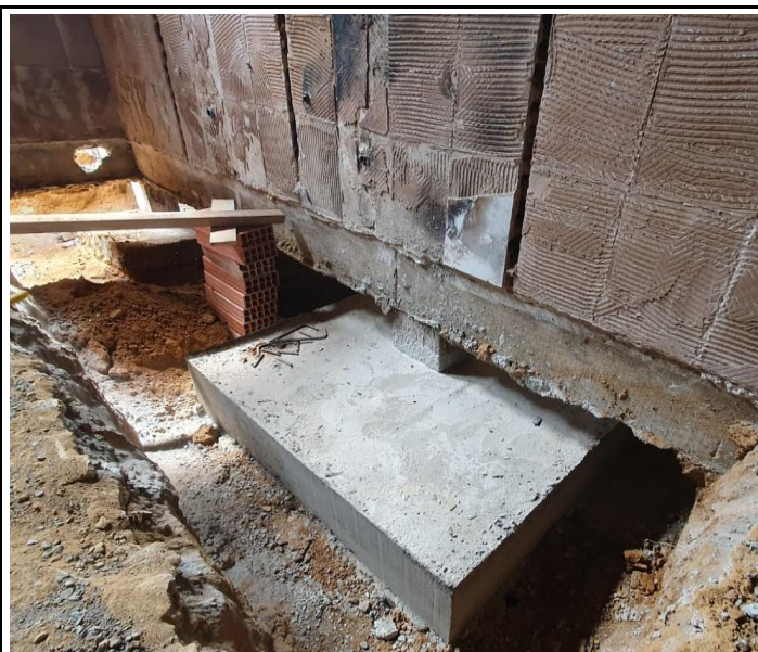
Foto 17 - Sapata concretada.
