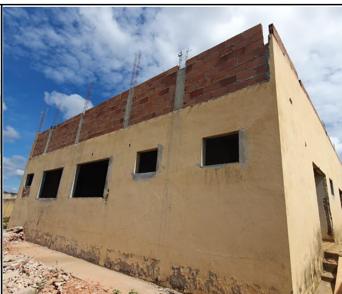
Foto 10 – Execução de platibanda em alvenaria.
