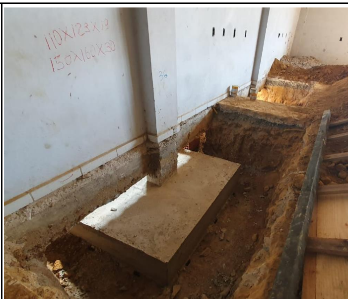
Foto 18 - Sapata concretada.
