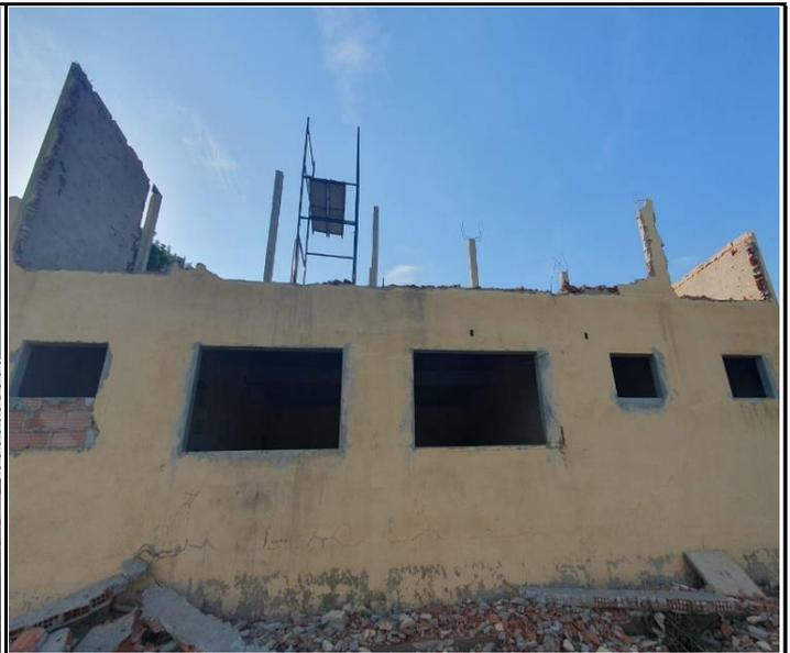
Foto 02 – Demolição de alvenaria da platibanda dos fundos
