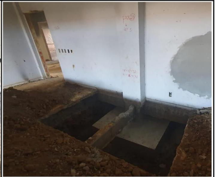
Foto 12 – Concretagem das sapatas.
