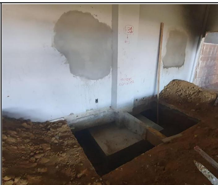
Foto 14 – Concretagem das sapatas.
