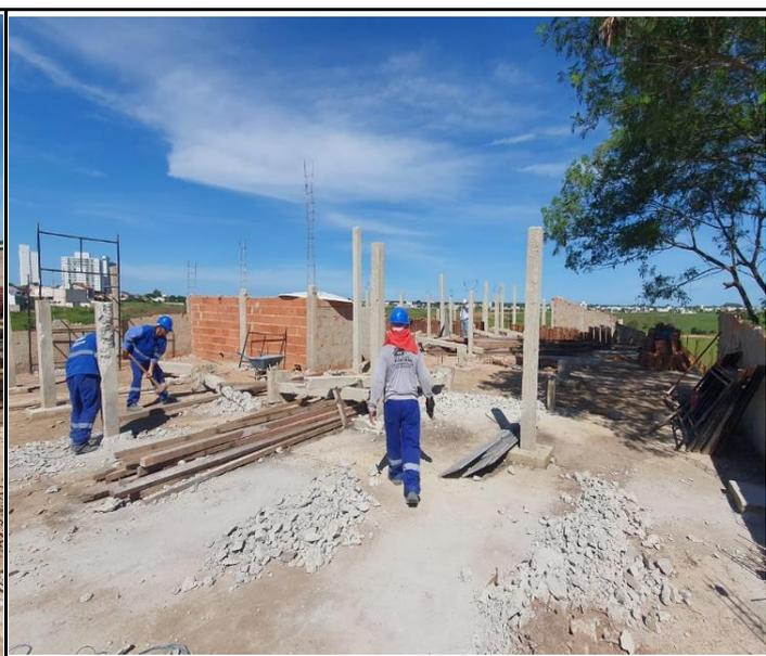
Foto 18 - Demolição de Pilares e Alvenaria das platibandas na cobertura.
