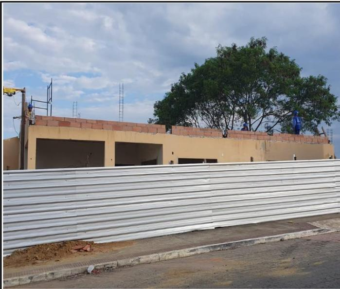
Foto 01 – Execução de Platibanda na fachada frontal.
