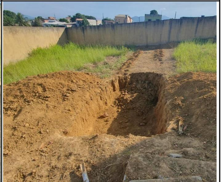
Foto 04 – Escavação manual para fundação do muro de contenção.
