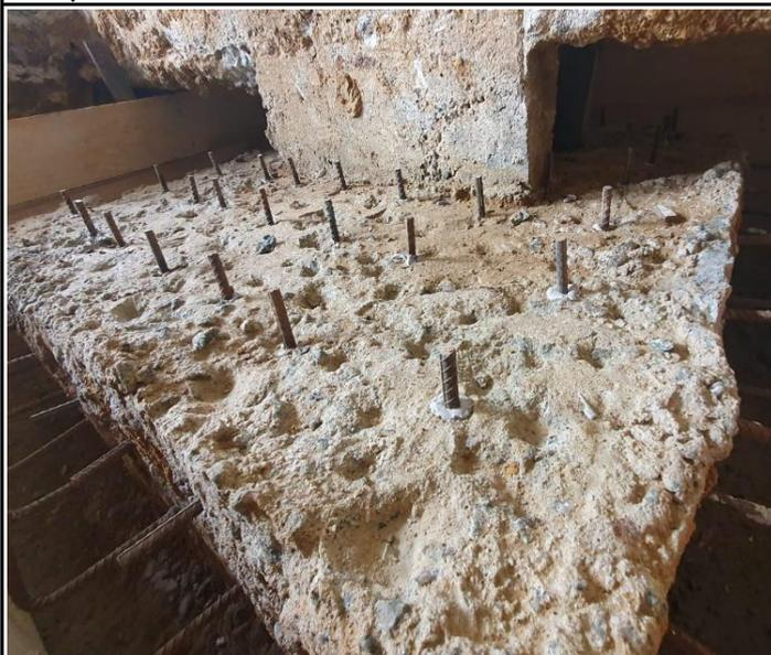
Foto 07 – Ancoragem de barras de aço CA-50 para reforço estrutural das Sapatas.
