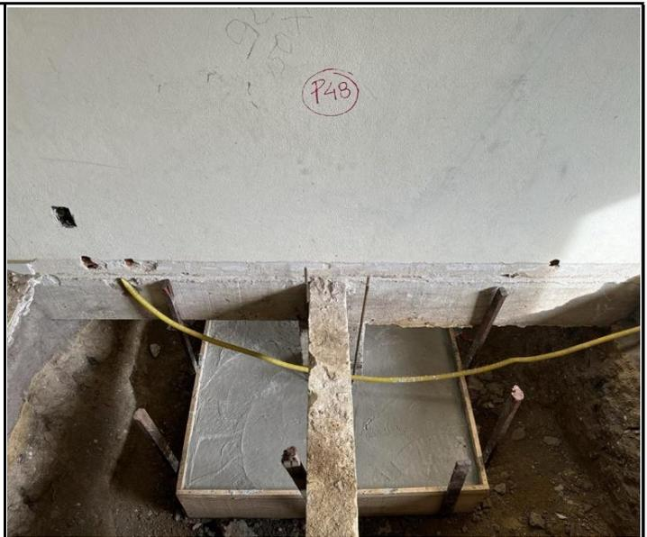
Foto 10 – Concretagem das sapatas.
