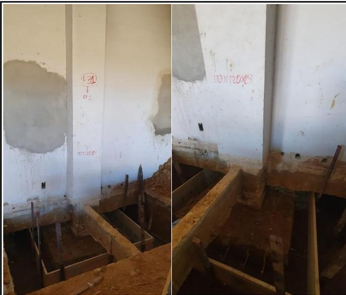
Foto 09 – Execução de forma para concretagem das Sapatas.
