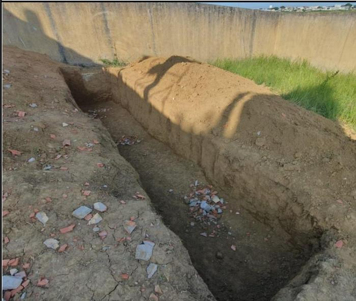
Foto 03 – Escavação manual para fundação do muro de contenção.
