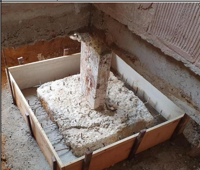
Foto 08 – Execução de forma para concretagem das Sapatas.
