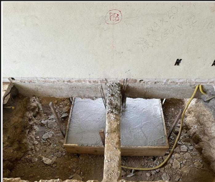
Foto 11 – Concretagem das sapatas.
