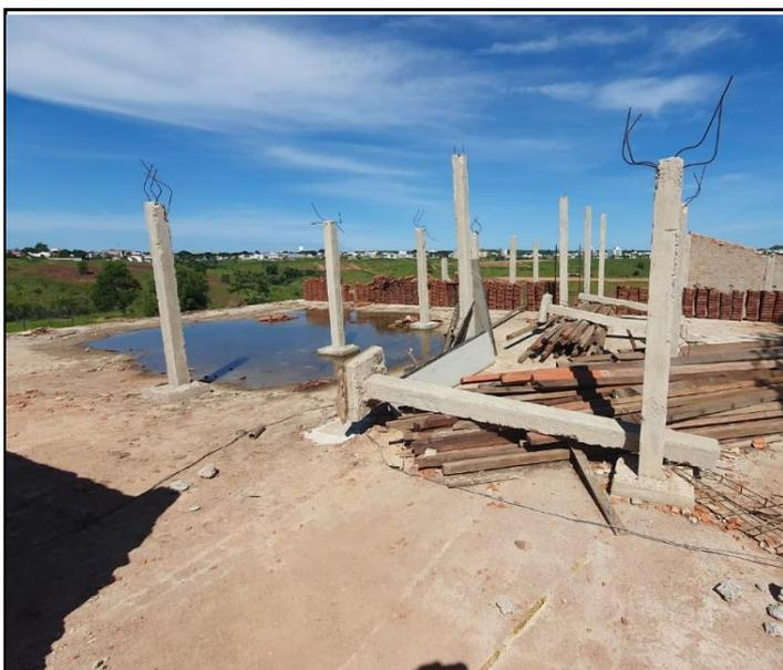
Foto 17 - Demolição de Pilares e Alvenaria das platibandas na cobertura.
