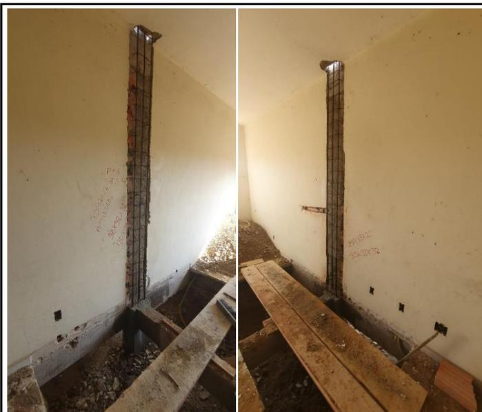
Foto 05 – Ancoragem de aço para reforço estrutural dos pilares P48 e P53.
