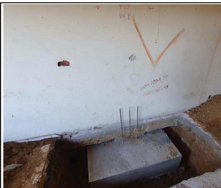
Foto 13 – Concretagem das sapatas.
