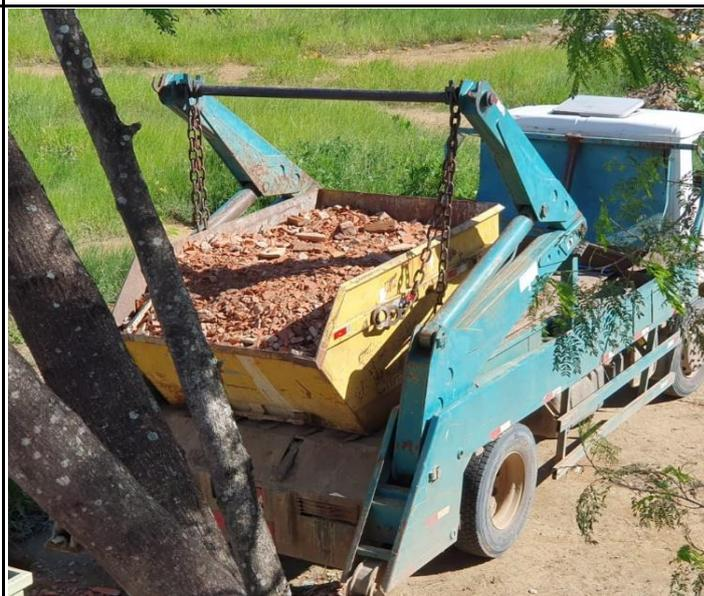
Foto 16 - Remoção de entulho decorrente das demolições da obra.
