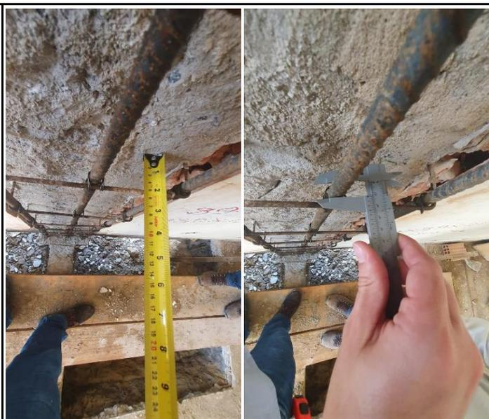
Foto 06 – Conferência de armação do do reforço estrutural dos pilares.
