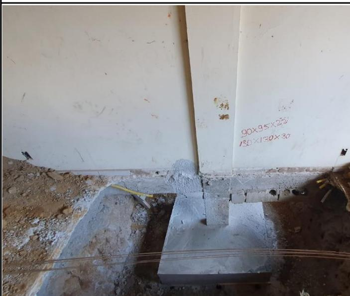
Foto 15 - Concretagem das sapatas.
