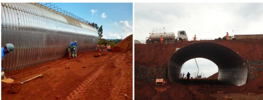
Figura 35: Execução passagens inferiores com chapas metálicas
