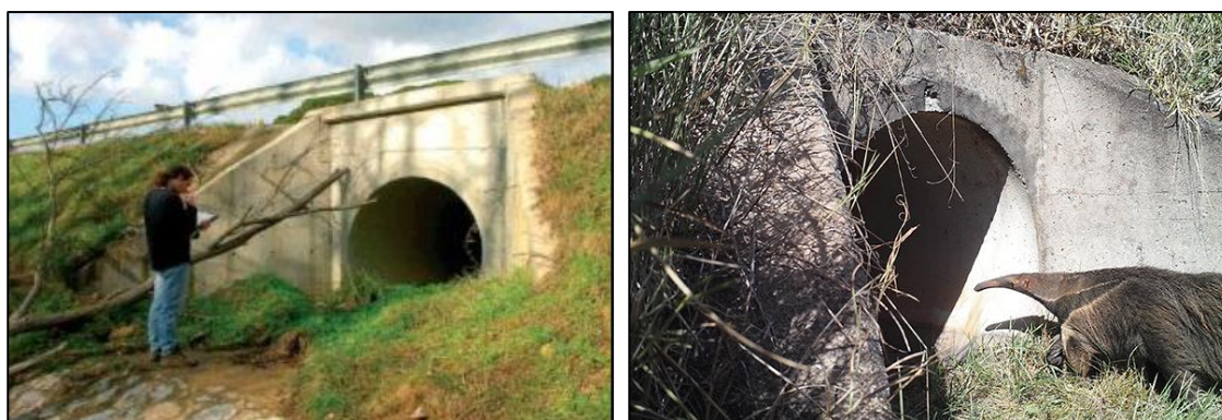
Figura 39: Modelos de passa fauna subterrâneo, juntamente com rela de condução para direcionamento da fauna.
