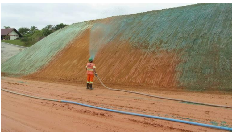
Figura 137: Aplicação da hidrossemeadura.
