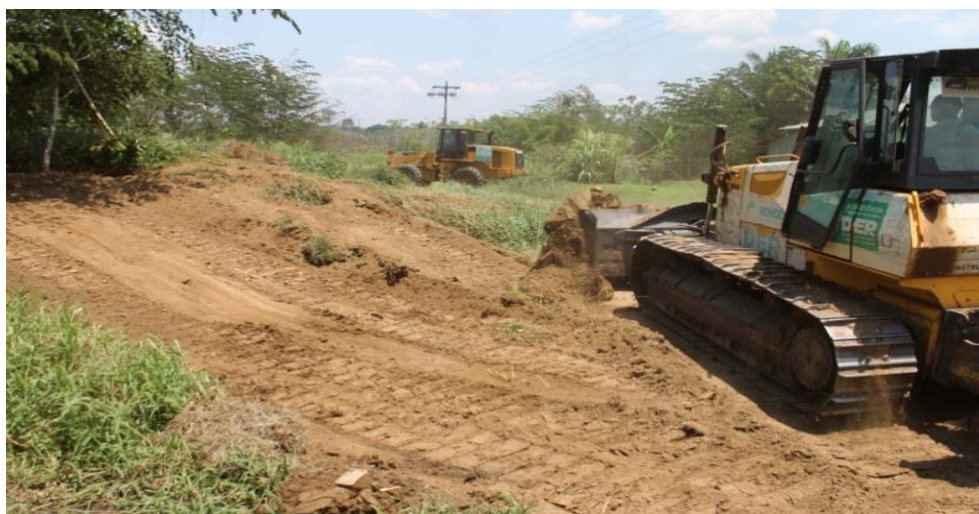
Figura 24: Trator realizando abertura de acesso conforme previsto para obra.
