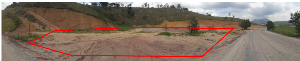
Figura 47 - Vista da área do canteiro Sul.
