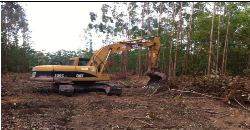
Figura 25: Processo de destoca com uso de escavadeira.
