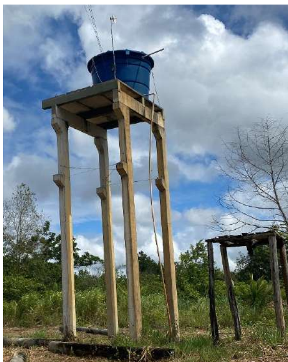
Figura 6-4: Reservatório, Aldeia Amarelos.
