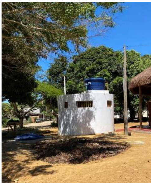
Figura 7-3: Banheiro com fossa, Aldeia Irajá.
