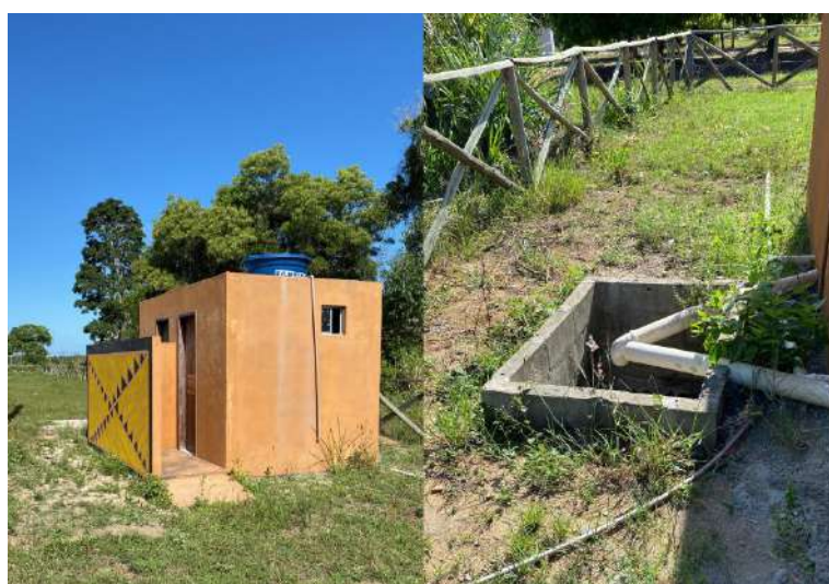
Figura 7-5: Banheiro com fossa, Aldeia Olho D'água.
