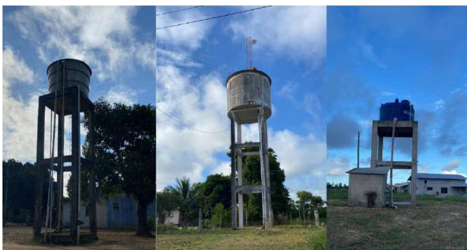
Figura 6-3: Reservatórios de água, Aldeia Pau Brasil.
