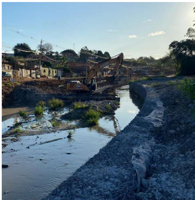
Figura 9-29: Obras no córrego Morobá na altura da rua Santa Luzia.
