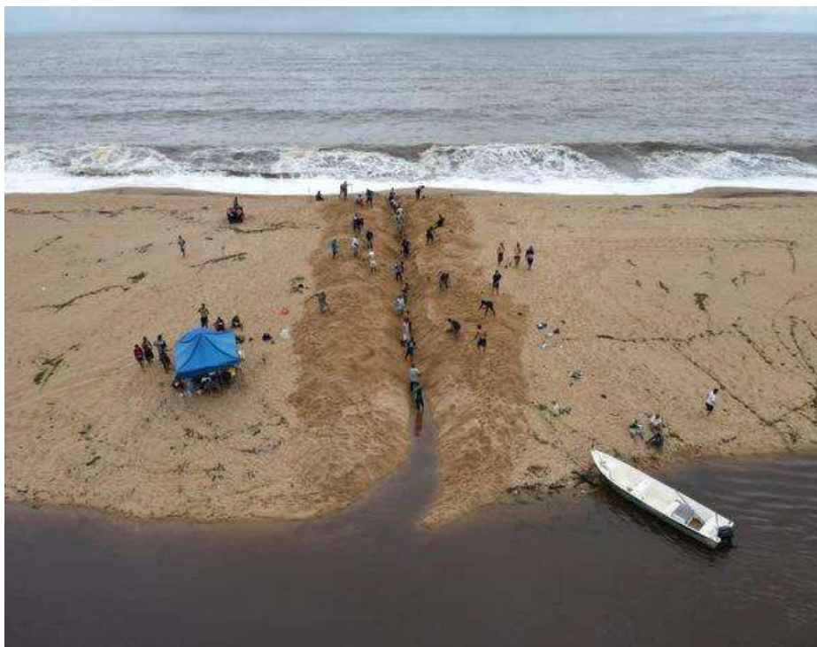
Figura 9-50: Moradores abrindo vala para que as águas do riacho possam chegar no mar, diminuindo assim as inundações em Barra do Riacho e Vila do Riacho.
