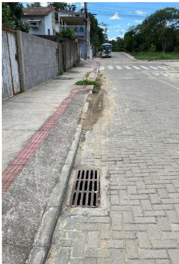
Figura 9-72: Rua Mário Valfré conta com infraestrutura de pavimentação e drenagem.
