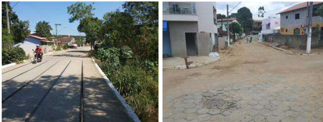
Figura 9-38: Ponte da travessia (a). Vista da Av. Aurélio Alvarenga (b).
