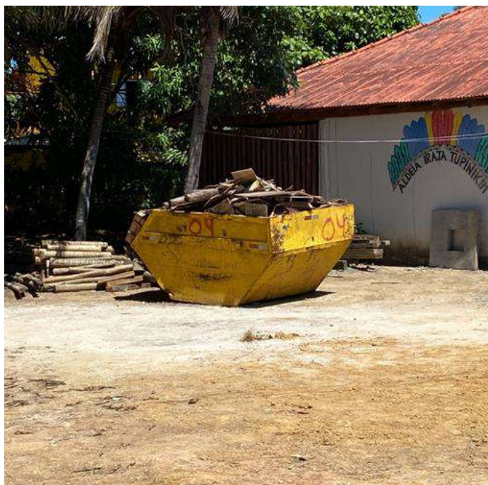
Figura 8-28: Caixa estacionária para descarte de resíduos de construção, Aldeia Irajá
