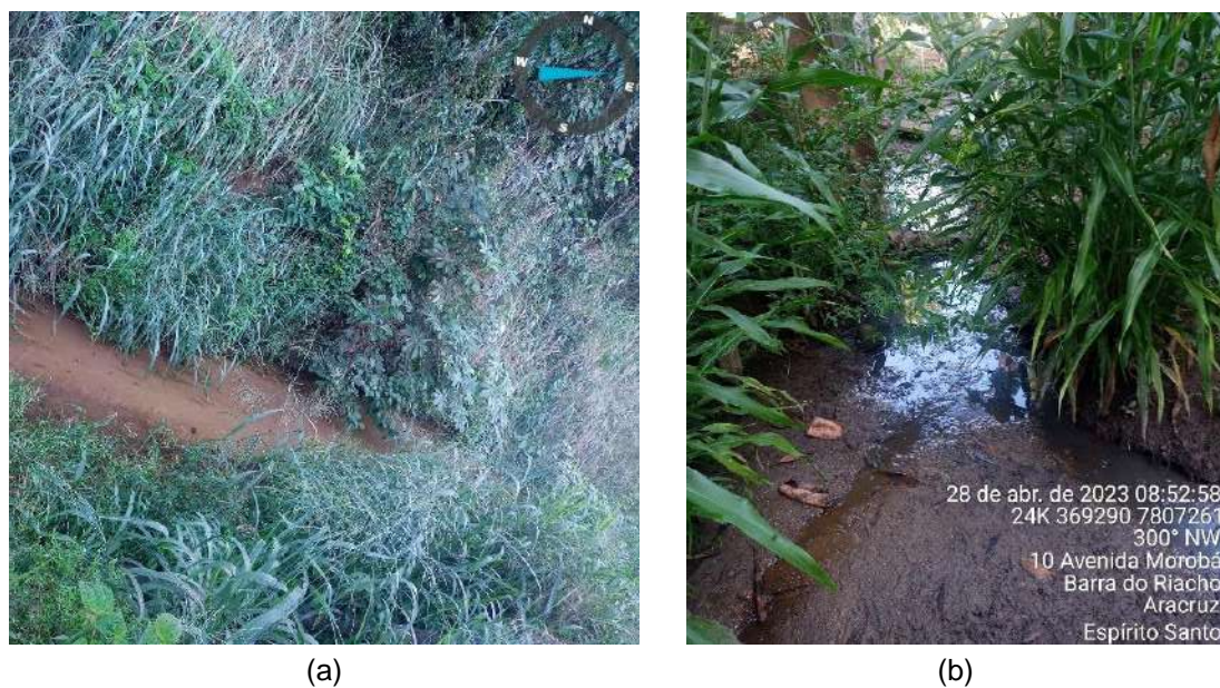
Figura 9-22: Córrego ainda apresenta assoreamento (a) e presença de esgoto (b)
