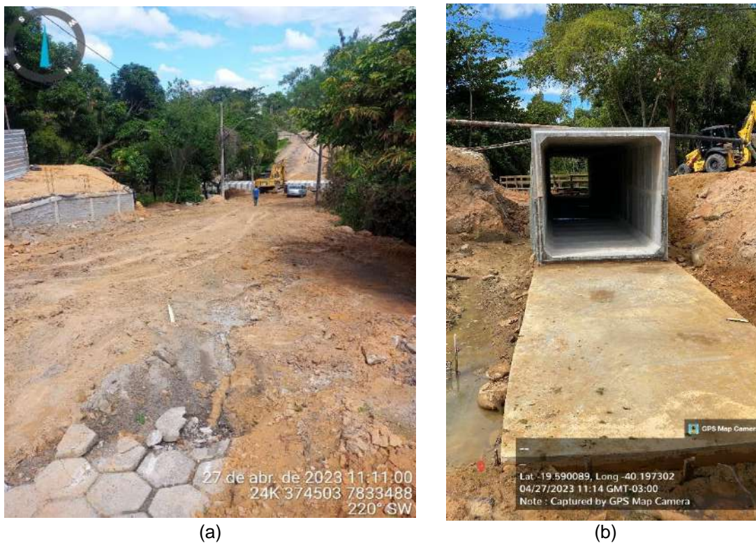
Figura 9-33: Reconstrução do bueiro no Córrego São José.
