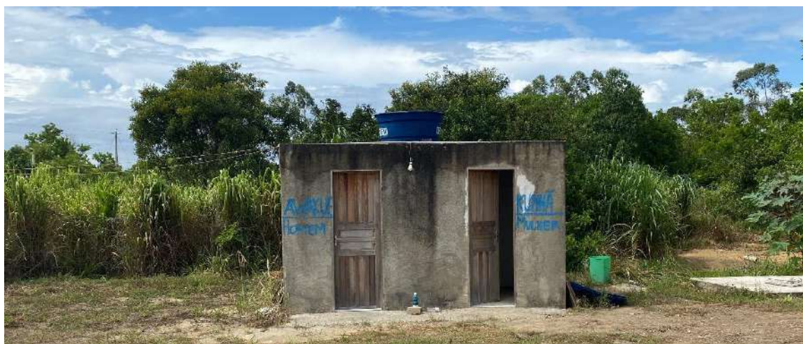
Figura 7-5: Banheiro, Aldeia Amarelos.
