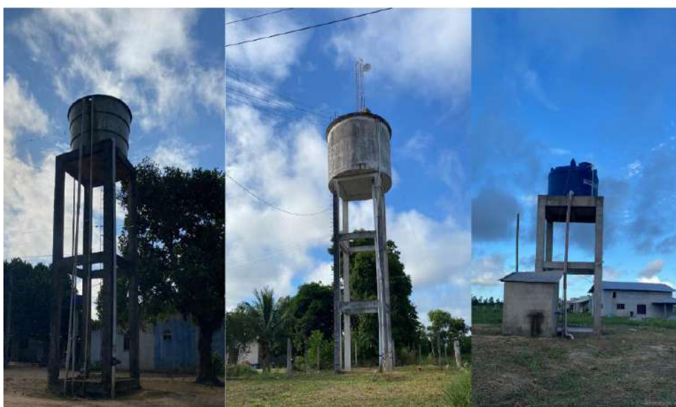
Figura 6-12: Reservatórios de água, Aldeia Pau Brasil.
